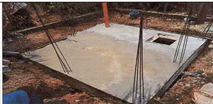
Foto 4: Finalización de Drenaje y Fosa Septica
