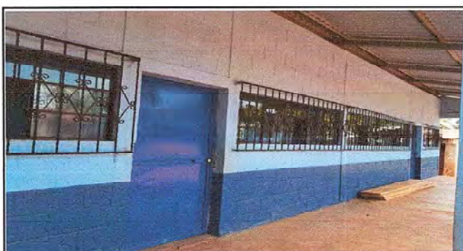
Foto 5: Finalización de cambio de vidrios de ventanas
